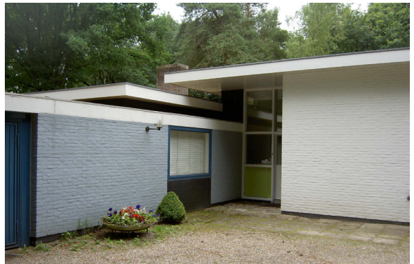
G.Th. Rietveld & J.B. van Grunsven, woonhuis Van Daalen \ Van Daalen house Bergeijk 1957 [foto MS]
